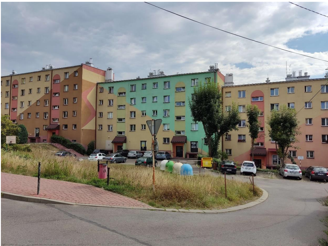
Ryc. 4 Zabudowa mieszkaniowa wielorodzinna w granicach opracowania
